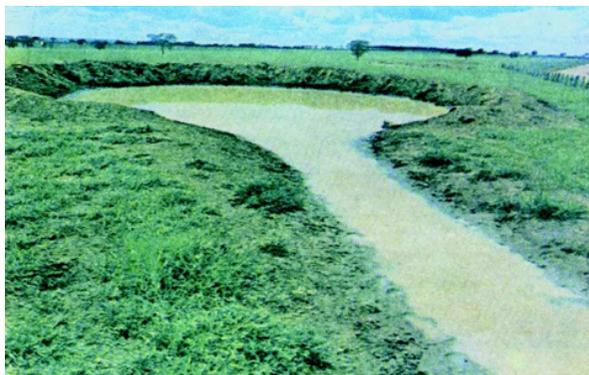
Figura 55 Bacia de retenção após o término da construção. Fonte: Acra (1984).
