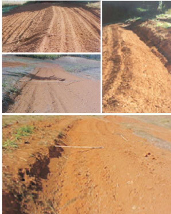
**Figura 37** Visão do terraço de base larga após o término da construção e medição da largura do canal.
