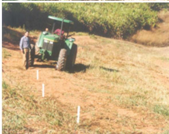
Figura 32 Posicionamento do trator para início da construção do terraço de base estreita.
