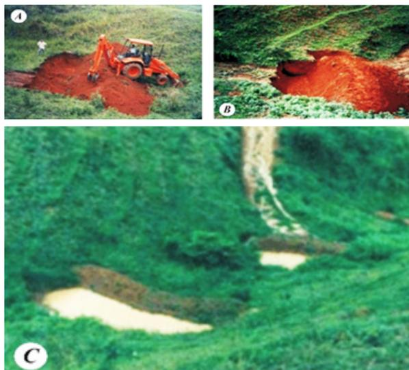
**Figura 45** Construção de bacias de retenção nos pontos de maior convergência das águas na encosta, utilizando retroescavadeira (A), detalhe da bacia pronta (B) e retendo água (C) proveniente do escoamento superficial, após a ocorrência de chuvas. (Cortesia de Edgley Pereira da Silva).
