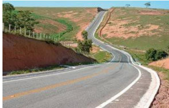
**Figura 49** Identificação de divisores de água nas estradas para locação das bacias de captação. Pontos altos das estradas indicando que a água corre para um determinado lado ou outro.
