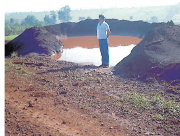
**Figura 47** Bacia de captação e retenção, armazenando água e evitando a erosão da estrada.
