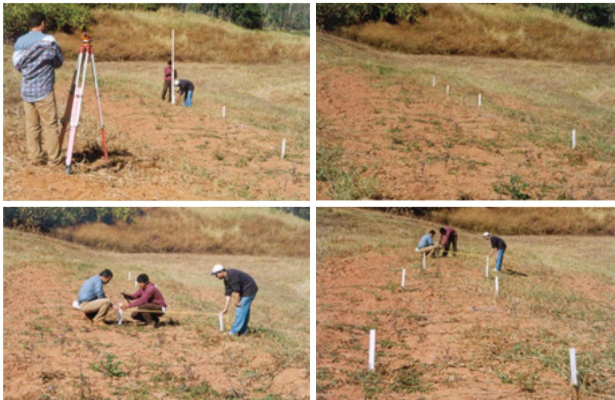
**Figura 24** Sequência de marcação da ilha (delimitada por estacas) utilizada para construção do terraço de base larga.
