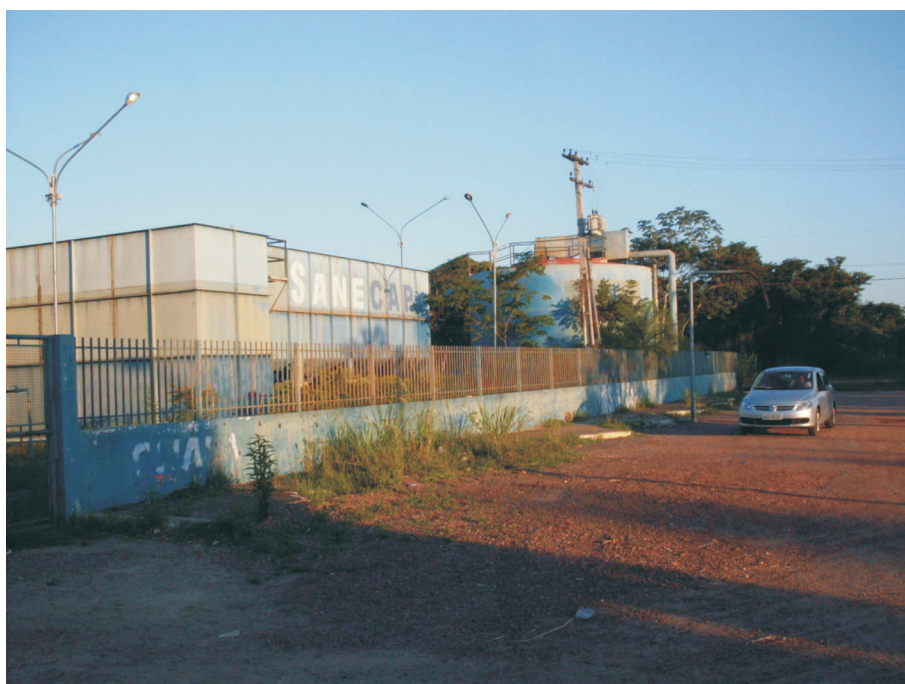
Figura 78 Estação de Tratamento de Esgoto que atende ao bairro COOPHEMA.
